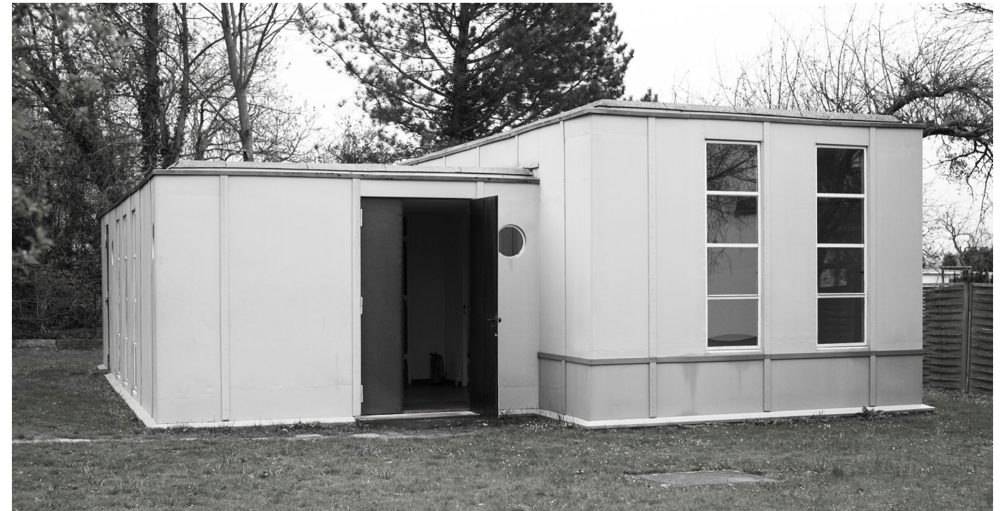
Stahlhaus mit Garten, Südstraße 3 Dessau-Törten, Foto: J. Wolf, 2017
